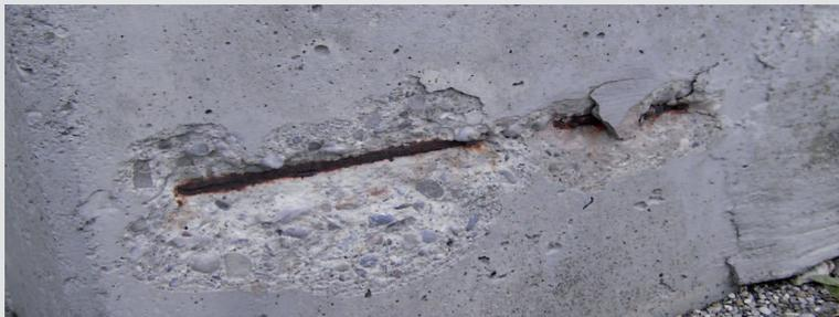
Karbonatisierung, ausgelöst durch in Hohlräume eindringende Feuchtigkeit, mit nachfolgender Bewehrungskorrosion und Abplatzungserscheinungen.
