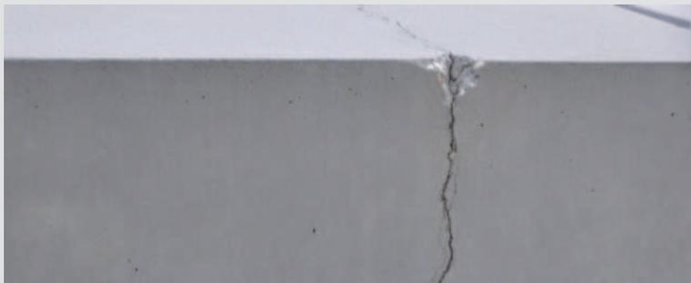
Rissbildung durch eindringen von Feuchtigkeit und anschließendem Gefrieren.
